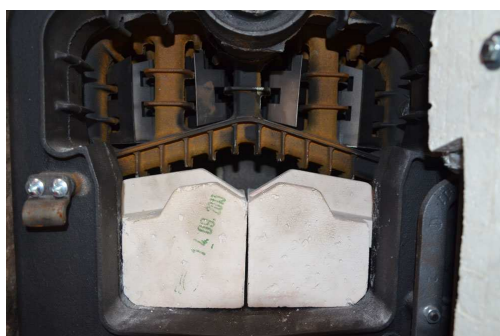
obr. č. 11 – vkládání turbulátorů a šamotových desek
